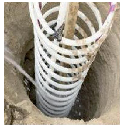
Schimbător de căldură cu pământul de tip elicoidal
